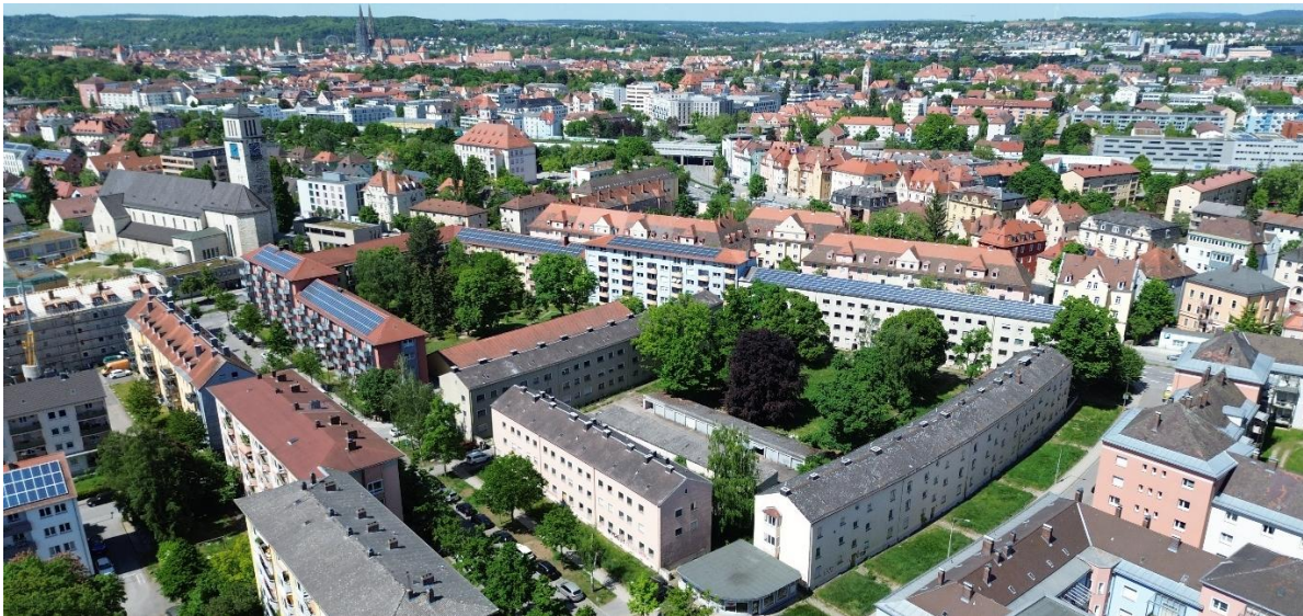
Aktueller Zustand des Postblockareals
