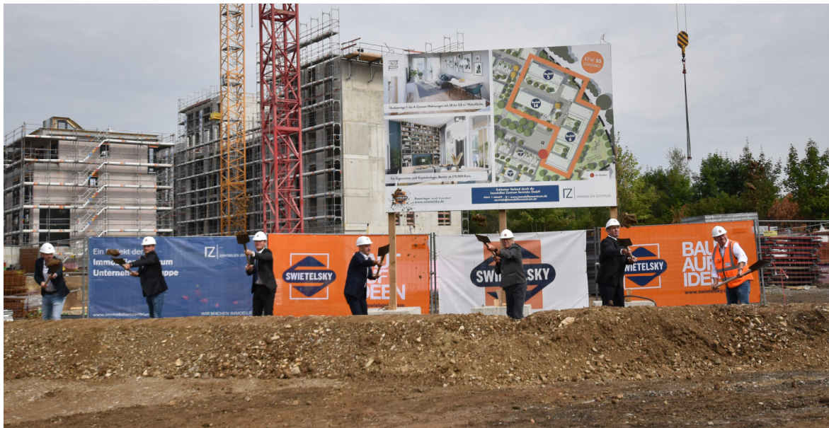
von links: Matthias Altmann (Altmann Ingenieurbüro), Dominik Straller (DS Architekten), Dr. Thomas Rosenkranz (Vorstand der Immobilien Zentrum Unternehmensgruppe), Ludwig Artinger (Bürgermeister), Wilhelm Schuhböck (Geschäftsführer der Swietelsky Baugesellschaft mbH), Andreas Böck (Bereichsleiter SF-Bau/Projektentwicklung Ingolstadt der Swietelsky Baugesellschaft mbH), Lutz Meyer (Bauleiter der Swietelsky Baugesellschaft mbH)
