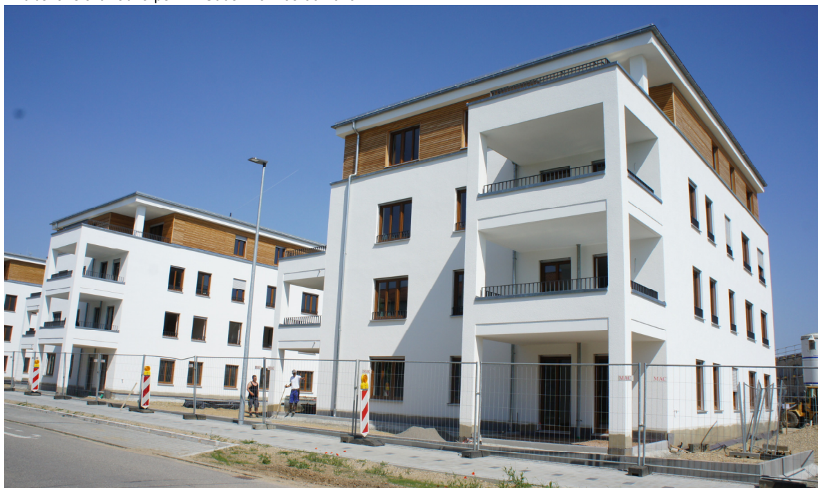
Außenansicht Baukörper 7 – Südosten vom 05.06.2019
